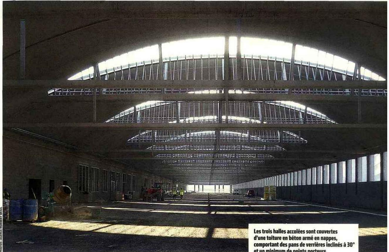
Les trois halles accolées sont couvertes d'une toiture en béton armé en nappes, comportant des pans de verrières inclinés à 30° et un minimum de points porteurs.
