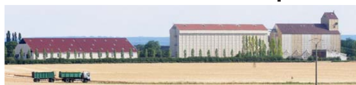
La coopérative s'est dotée de 13.000 t de capacités supplémentaires pour pouvoir « étaler les dégagements » désormais réalisés par camions. Photo : Dijon Céréales
