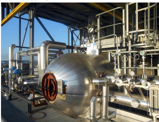
Vue sur un ballon chaudière
