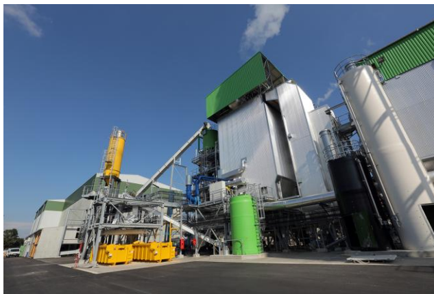
Vue générale de l'unité ROBIN
