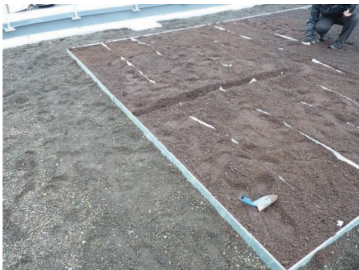
Figure 10 : Préparation de la zone d'essai : insertion de séparations en géotextile
