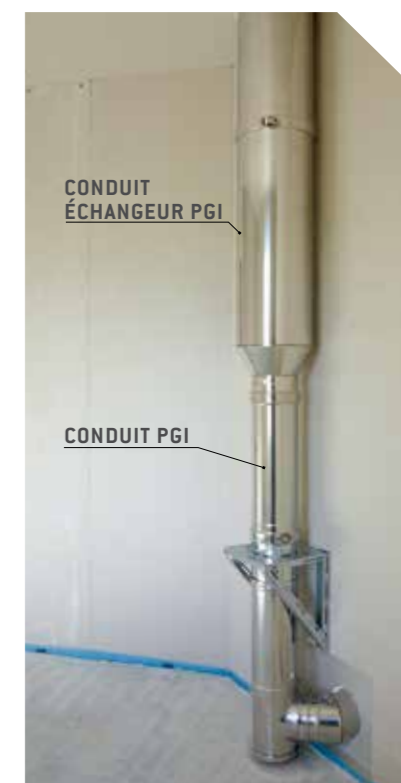
Raccordement à l'arrière du poêle à granulés avant coffrage dans la pièce adjacente
