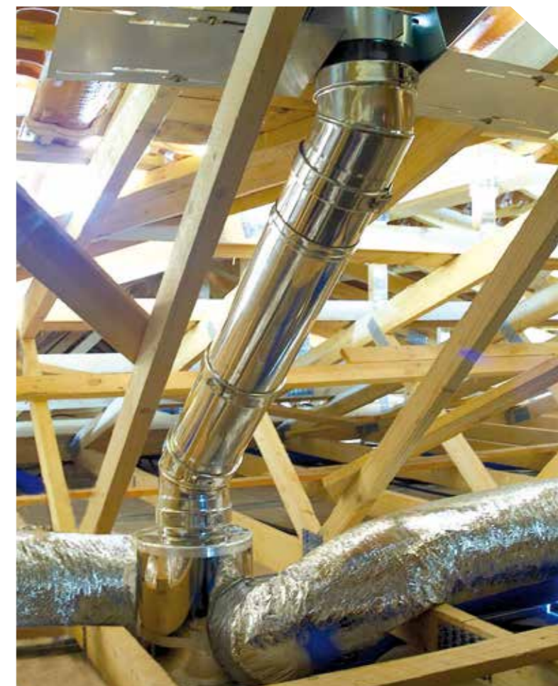
Raccordement de l'échangeur aux gaines de la VMC double flux
