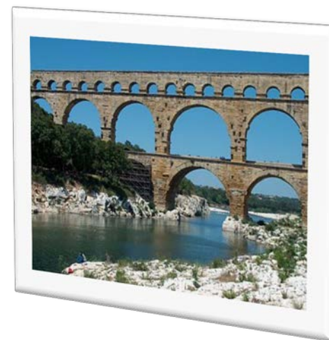
Le Pont du Gard (France) construit au 1 er siècle
