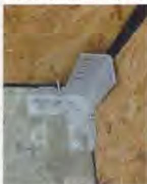
géométrique. Ainsi, lorsque le mur descend à proximité de l'équerre, la tête du tire-fond s'engage verticalement dans l'encoche de l'équerre prévue à cet effet. Seul le corps du tire-fond peut glisser dans l'encoche (**photo de gauche**). Une fois le mur posé complètement sur la dalle en béton, le mur est
