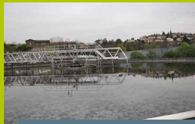
La station d'épuration
